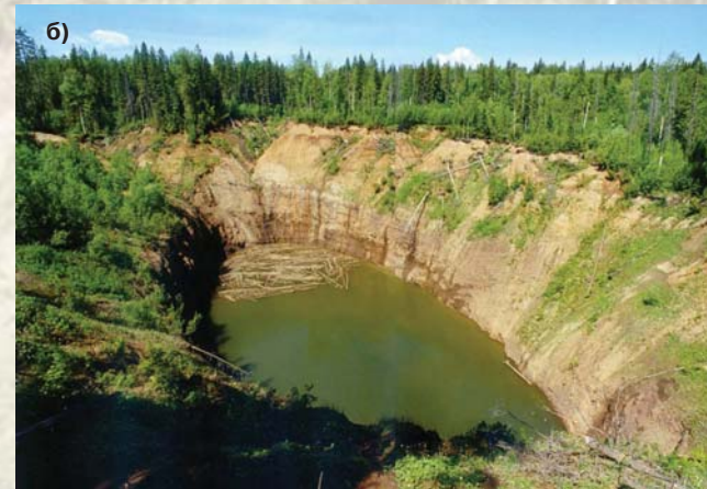
Рис. 1. Деформация земной поверхности на рудниках БКРУ-1 (а) и БКРУ-3 (б)
