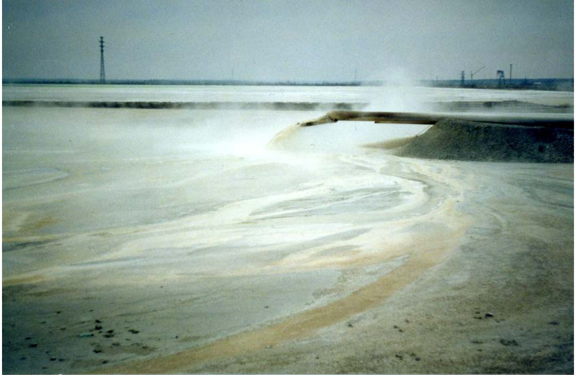
Рис. Действующий шламонакопитель Березниковского содового завода. Справа на заднем плане виден пульпопровод с изливающейся из него струей шлама.
